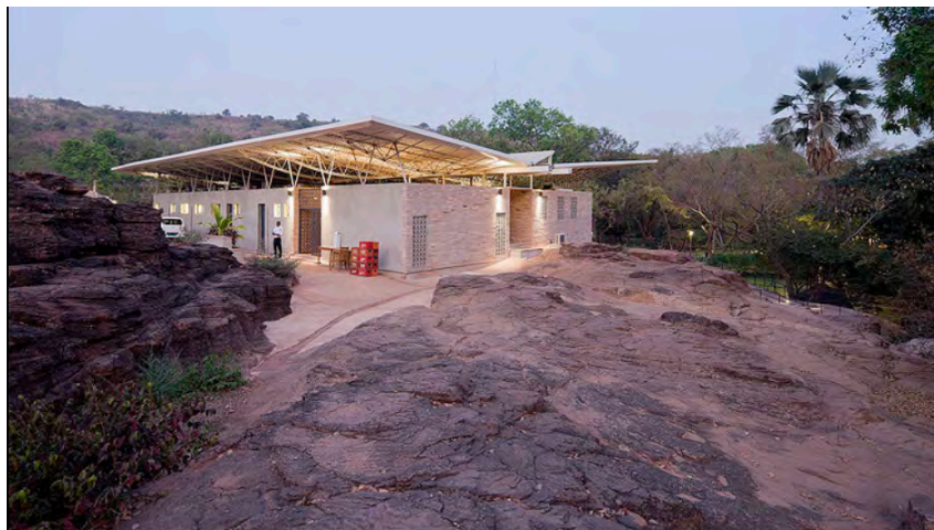
Рис. 3. Архитектурные объекты на территории парка.
